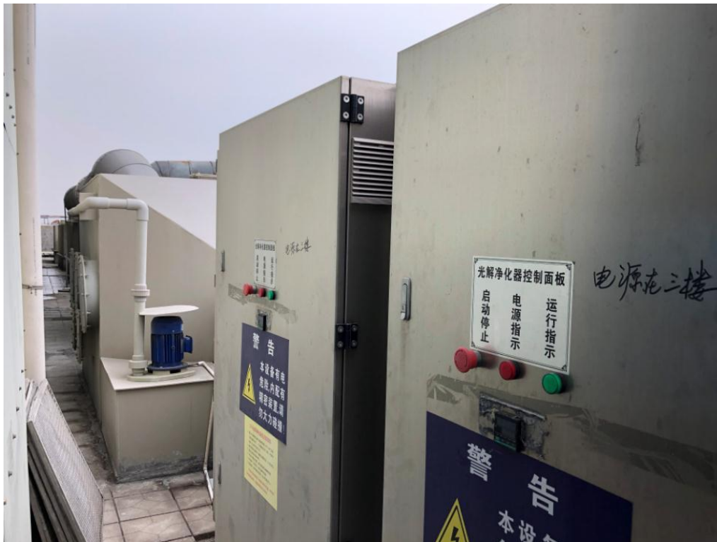
图 3.7-2 喷漆和烘烤废气处理装置
